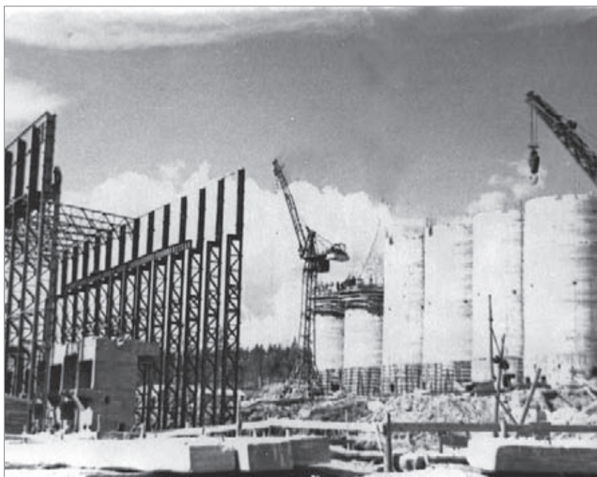
Ведётся монтаж корпуса ¾ участка дробления обогащительной фабрики
